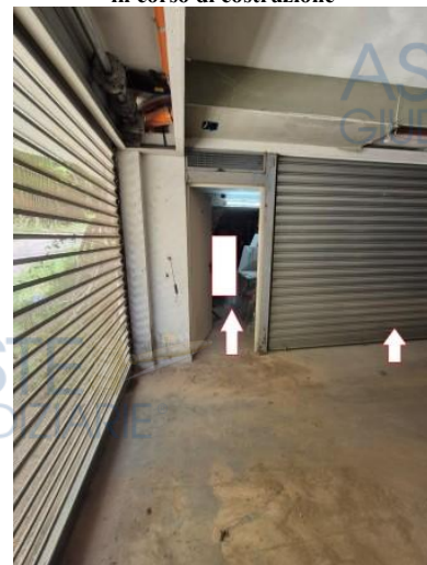
Figura 11 accesso al box auto del piano seminterrato
