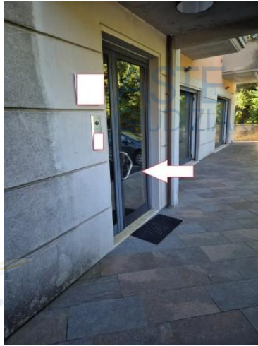
Figura 6 accesso al vano scala comune del fabbricato
