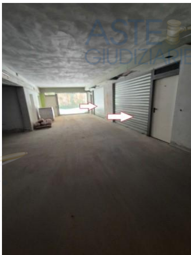
Figura 10 accesso al box auto del piano seminterrato
