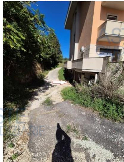
Figura 9 rampa carrabile per accesso al piano seminterrato in corso di costruzione
