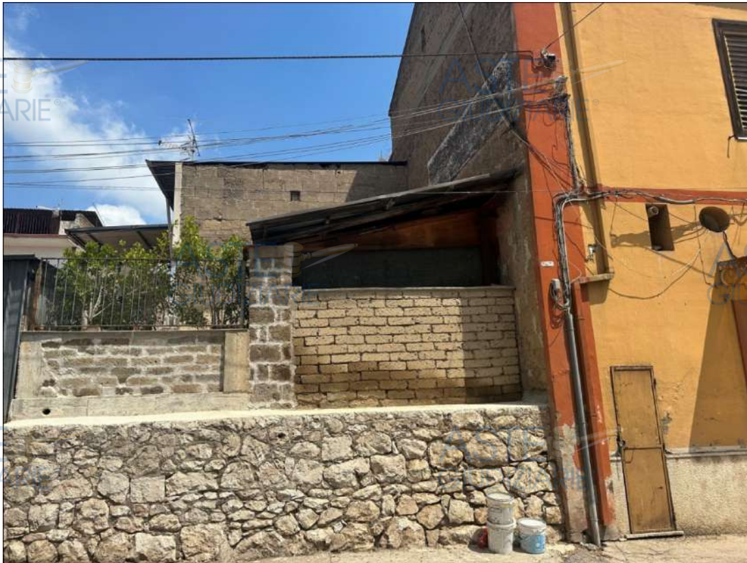
FOTO: FACCIATA LATERALE DELL'IMMOBILE N°2 – PIANO TERRA (Foglio: 11 - Particella - 274)
