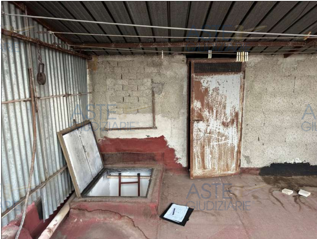
FOTO: BOTOLA PER ACCEDERE AL TERRAZZO DI COPERTURA DELL'IMMOBILE N°1
