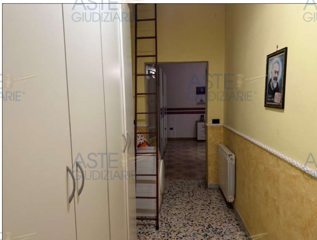
FOTO: SCALA IN PIOLI IN FERRO DEL VANO DISIMPEGNO PER ACCEDERE AL TERRAZZO DI COPERTURA
