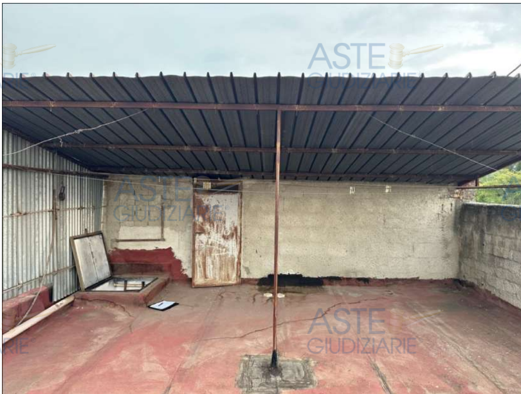
FOTO: TERRAZZO DI COPERTURA CON LAMIERA DELL'IMMOBILE N°1
