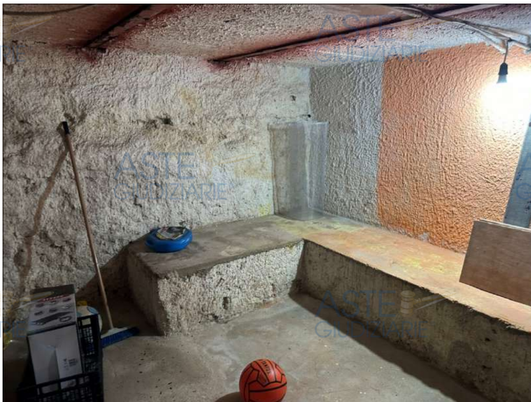
FOTO: VANO CANTINA DELL'IMMOBILE N°1 – PIANO INTERRATO (Foglio: 11 - Particella - 5026 – Sub
