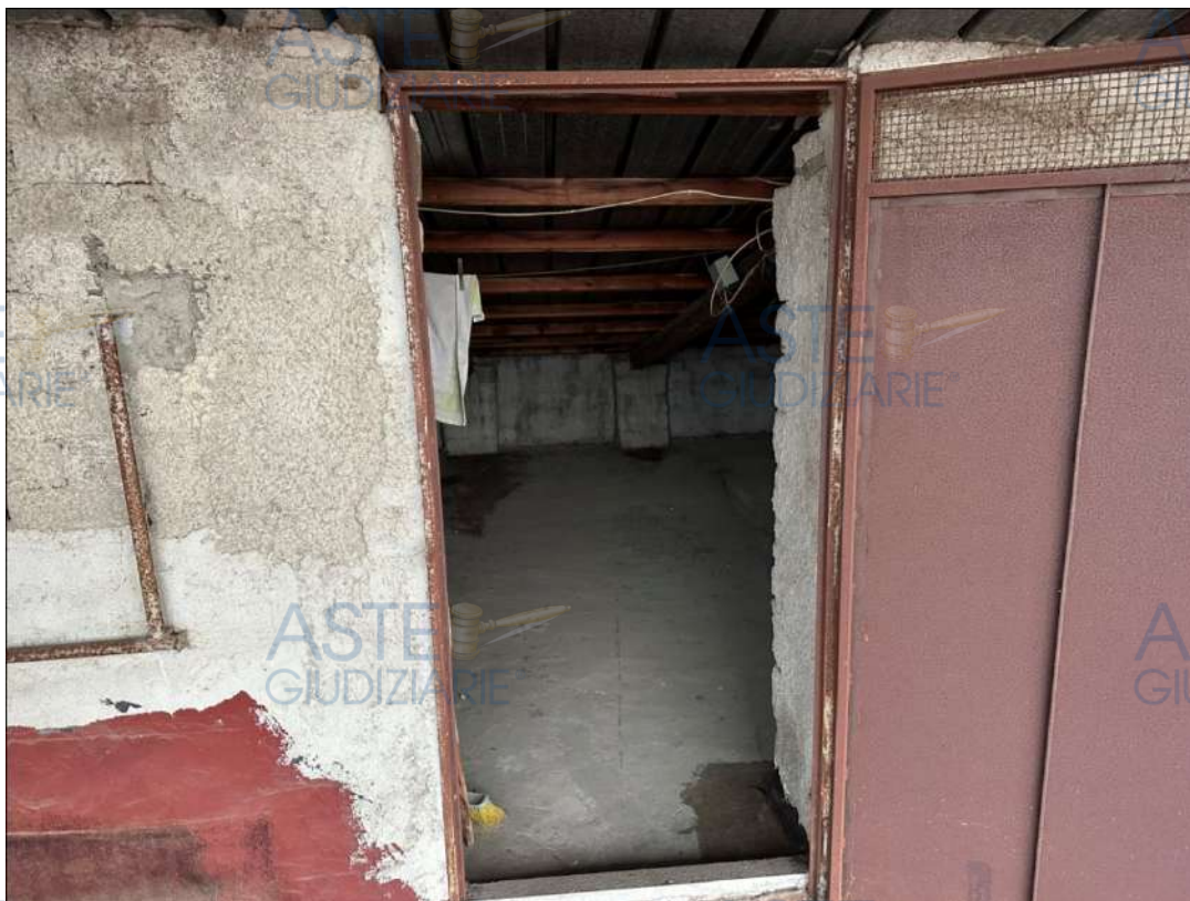
FOTO: PORTA IN FERRO PER ACCEDERE AL PIANO SOTTOTETTO DELL'IMMOBILE N°1
