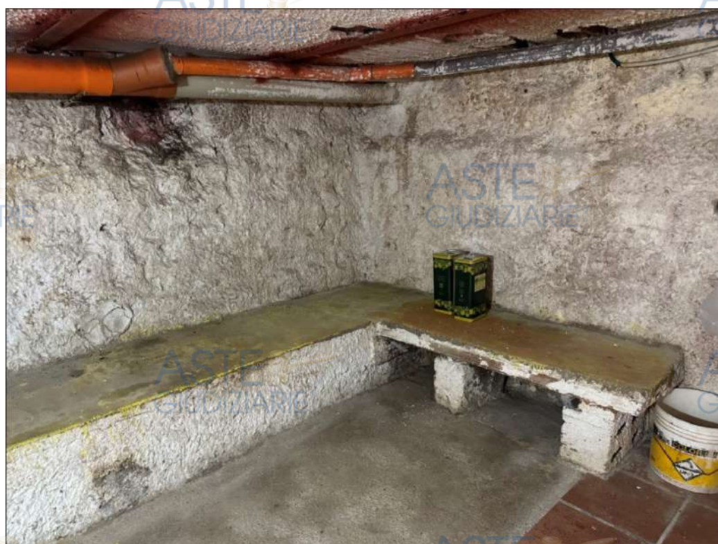
FOTO: VANO CANTINA DELL'IMMOBILE N°1 – PIANO INTERRATO (Foglio: 11 - Particella - 5026 – Sub 8)
