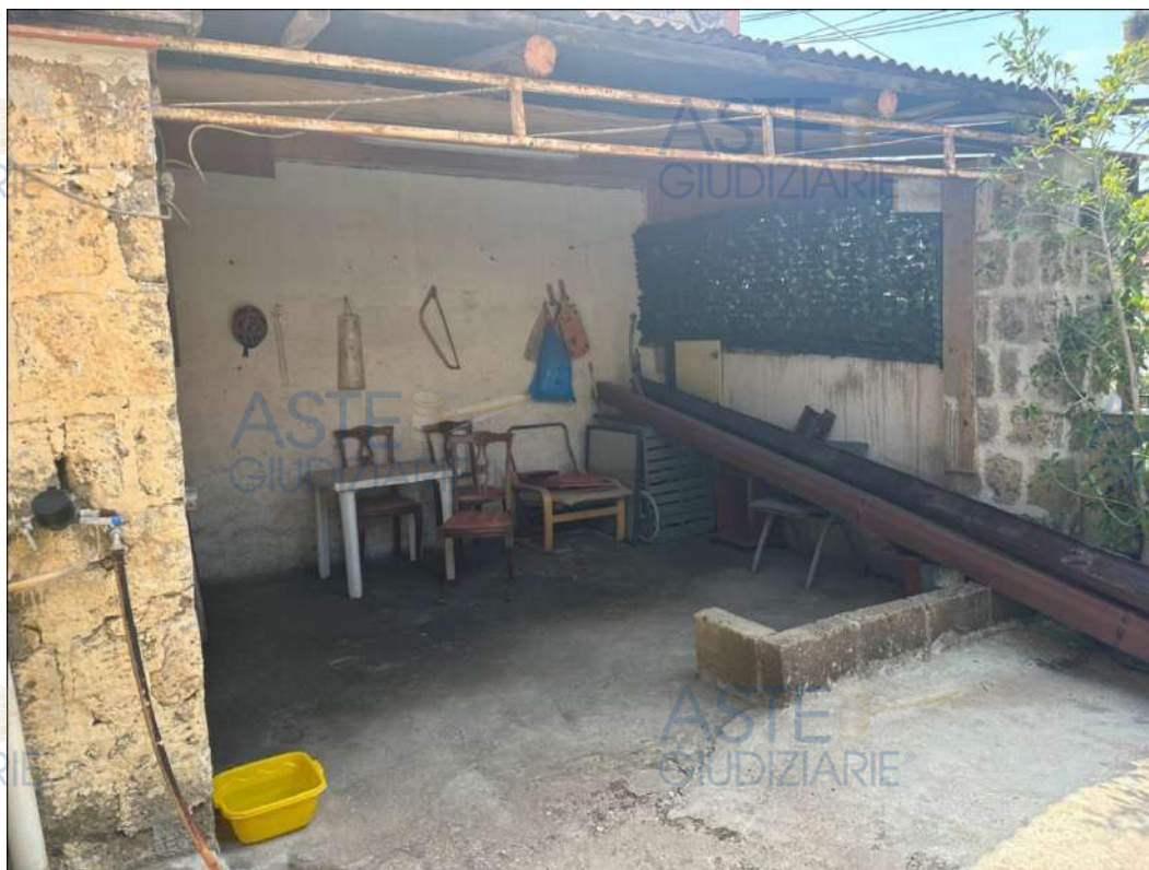
FOTO: VANO DEPOSITO CON TETTOIA DELL'IMMOBILE N°2 - PIANO TERRA (Foglio: 11 - Particella - 274)
