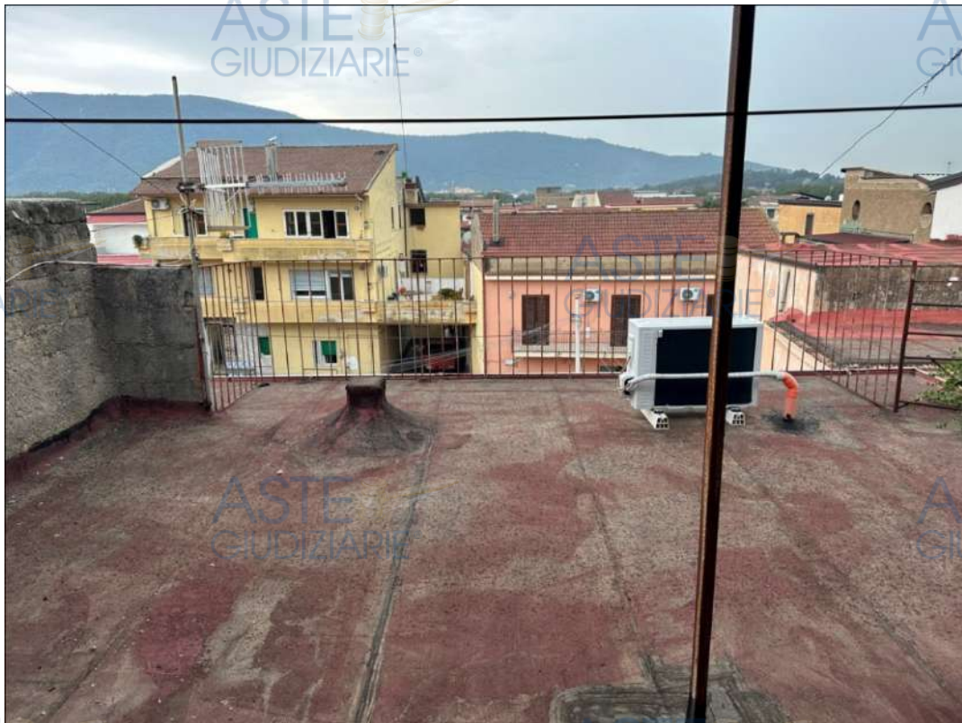
FOTO: TERRAZZO DI COPERTURA DELL'IMMOBILE N°1
