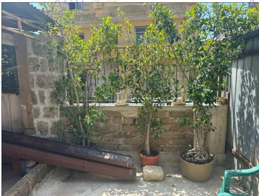
FOTO: MURETTO DEL CORTILE DELL'IMMOBILE N°2 - PIANO TERRA (Foglio: 11 - Particella - 274)
