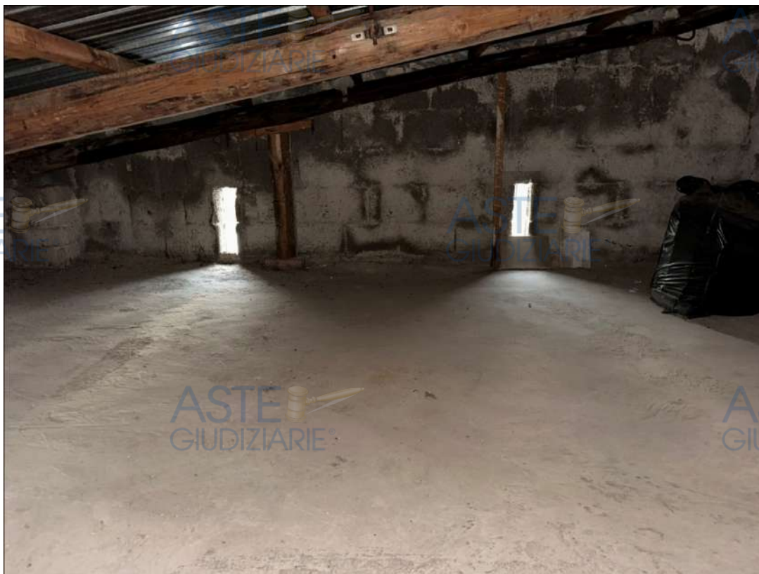
FOTO: PIANO SOTTOTETTO DELL'IMMOBILE N°1 – (Vano non accatastato)
