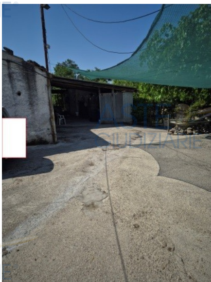
Figura 8 cortile pertinenziale al LOTTO UNICO
