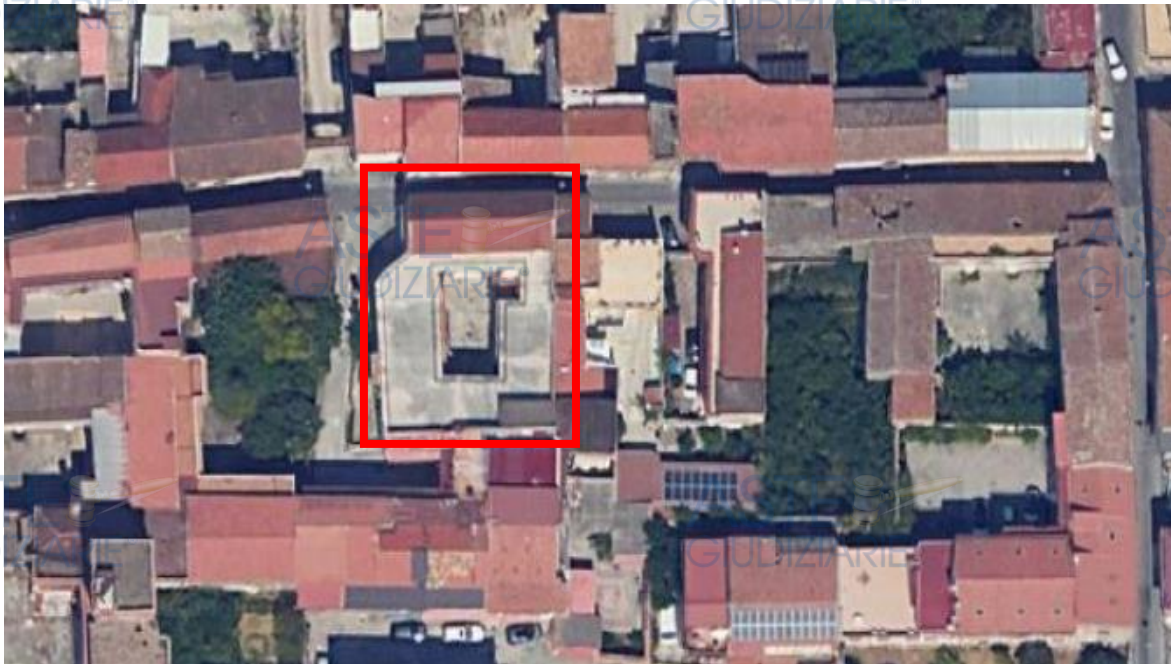
Comune Casapulla (CE), via Giacomo Stroffolini n. 20 Vista del fabbricato in cui è inserito l'immobile - Foglio 5, p.lla 5095, sub. 15
