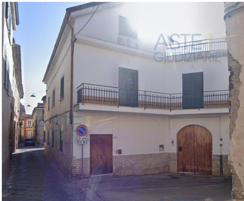
Vista del fabbricato foglio 5, p.lla 5095 dalla via Giacomo Stroffolini in cui è inserito l'immobile sub. 15 oggetto di pignoramento
