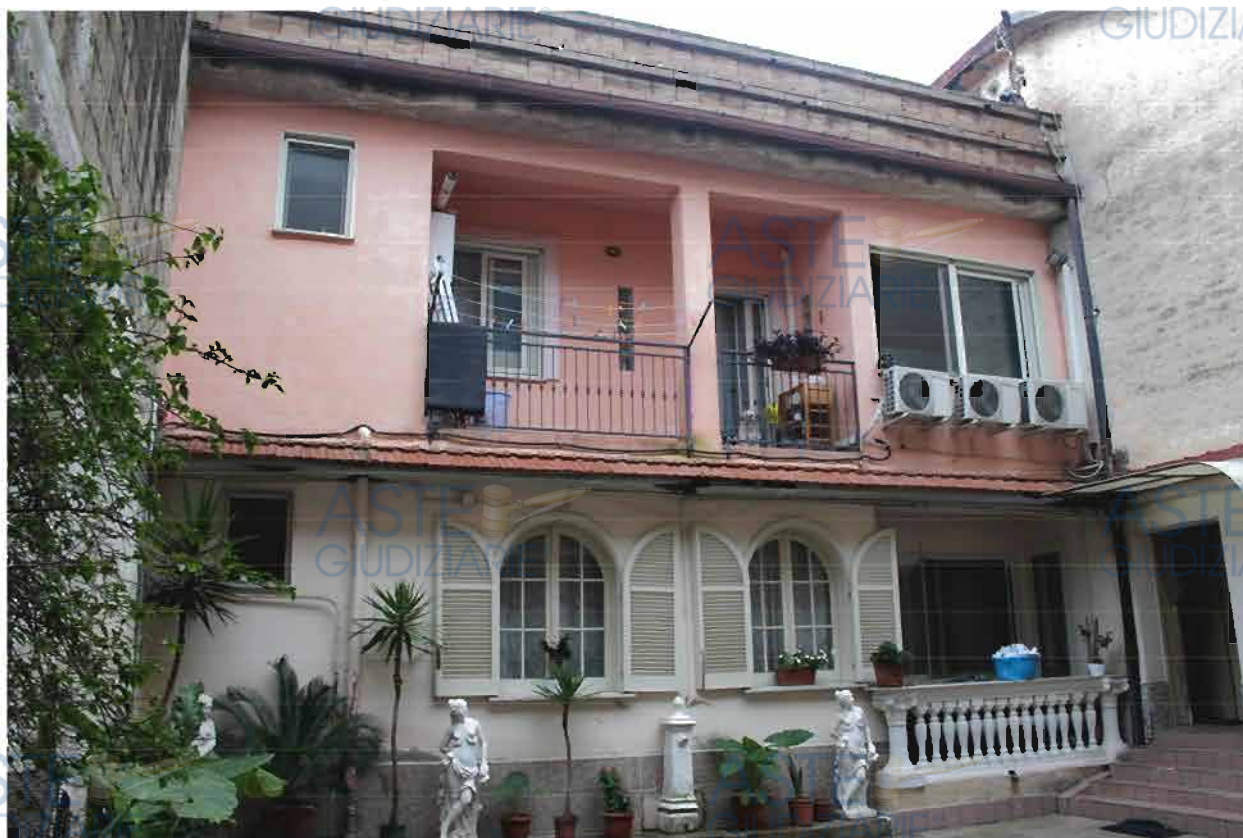
Prospetto del fabbricato
