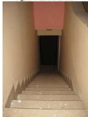
Figura 20 scala per accesso al secondo piano
