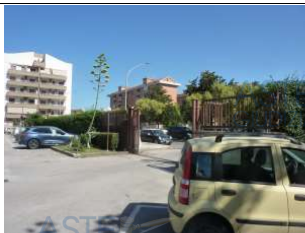
Foto 20 – Prospetto anteriore su via Salzillo
