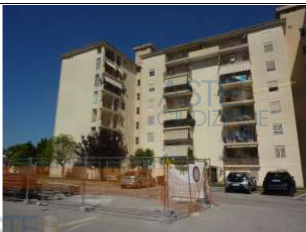
Foto 19 – Prospetto posteriore su via Perla
