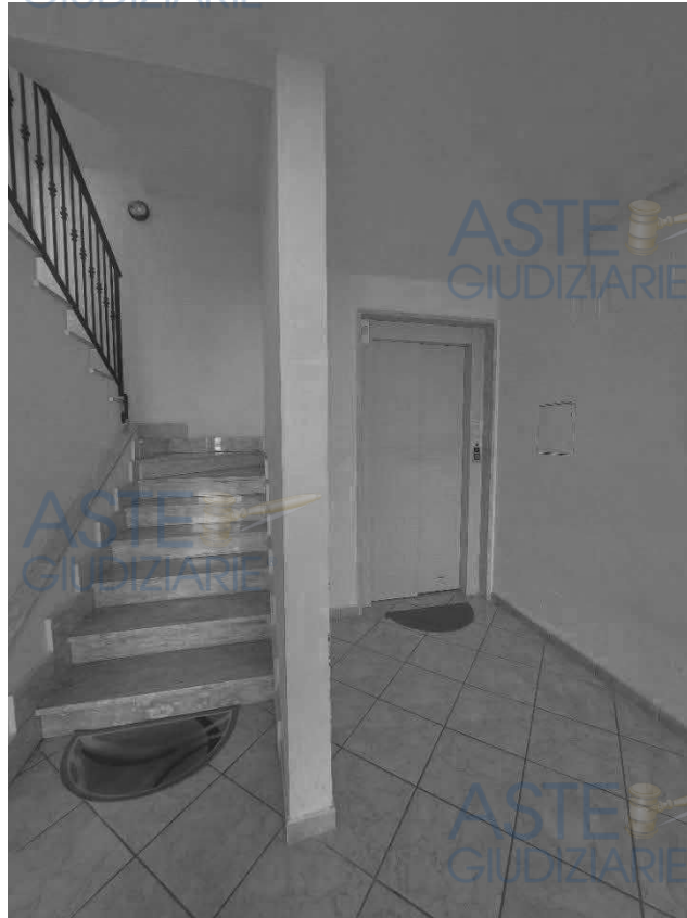
atrio fabbricato scala C
