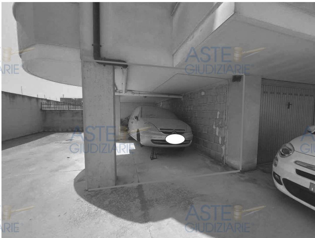
Fabbricato scala C - versante nord - bene 2
