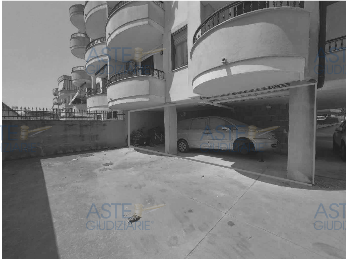
Fabbricato scala C – versante est - bene 2
