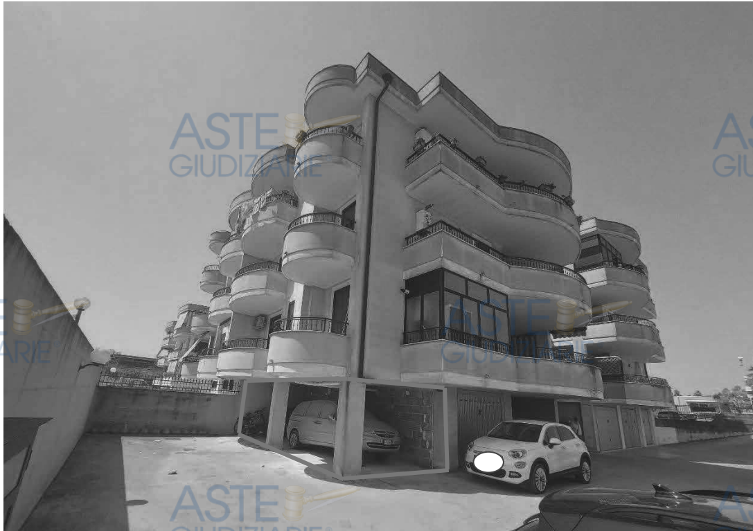
Fabbricato scala C - Indicazione bene 2
