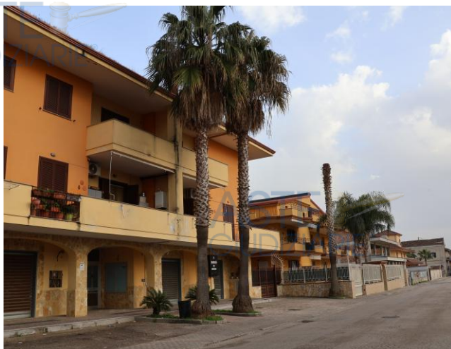
Prospetto fabbricato lungo via XI Settembre
