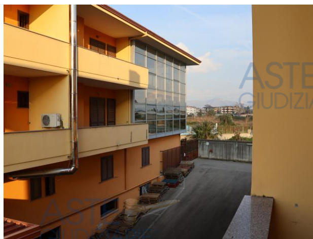
Rampa di accesso ai garage
