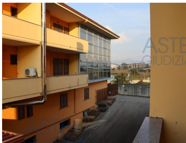
Rampa di accesso ai garage
