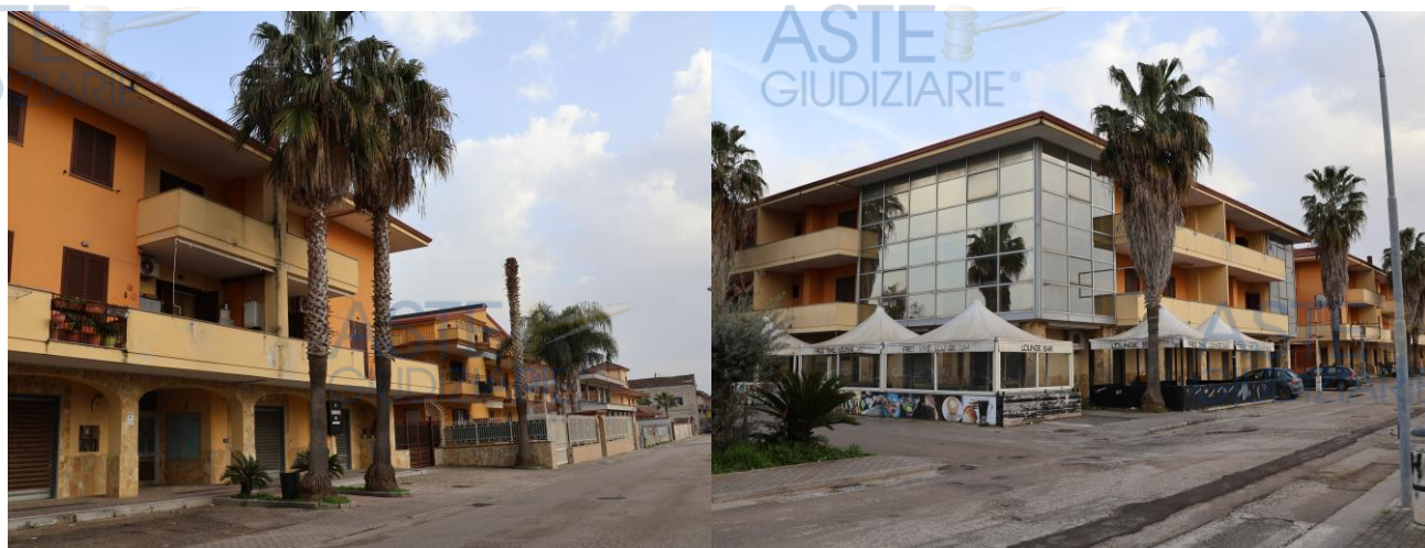
Prospetto fabbricato lungo via XI Settembre
