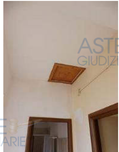
_corridoio e botola per il soffitto
