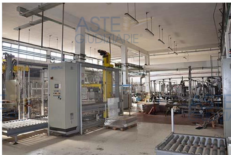
imm2.22: sala lavorazione corpo di fabbrica C
