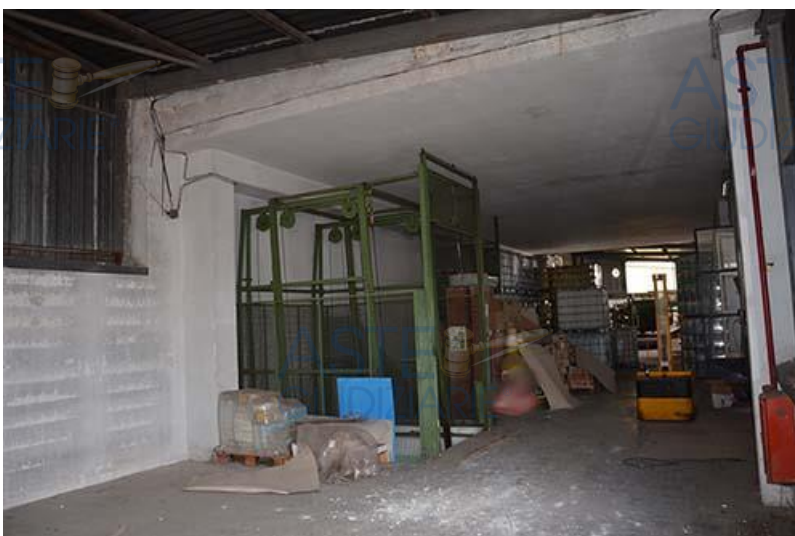
imm2.49: scala di servizio con montacarichi
