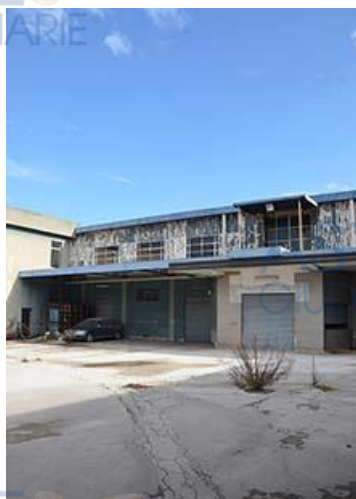
imm2.09: viste dal piazzale interno
