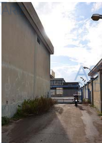
imm2.07: ingresso al piazzale
