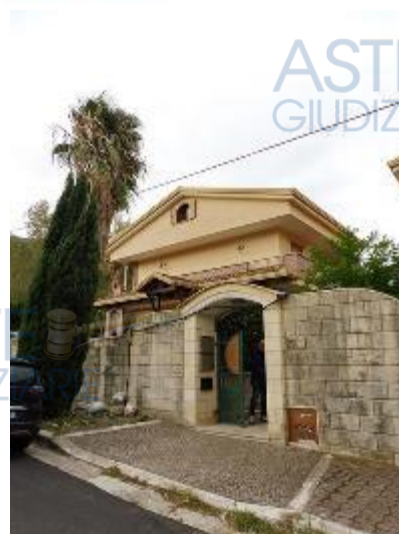
_viste della strada
