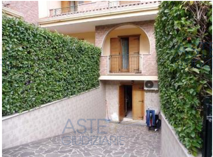
ASTE GIUDIZIARIE _accesso al seminterrato dalla rampa esterna
