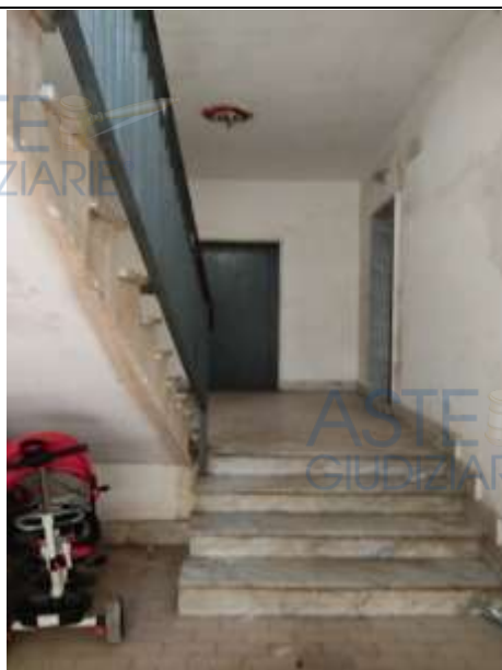
Foto 3 – Androne di ingresso
