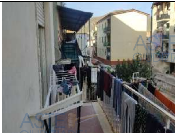
Foto 14 – Vista terrazzo lato Est
