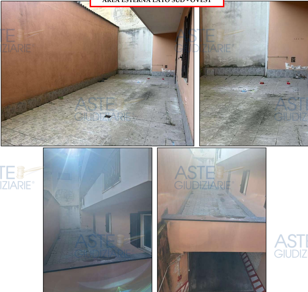
AREA ESTERNA LATO SUD - OVEST
