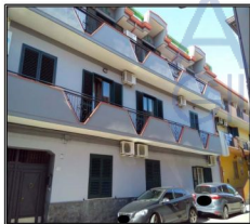
Figura 6 Facciata fabbricato su via Cadorna
