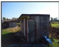
Figura S7 fabbricato in muratura
