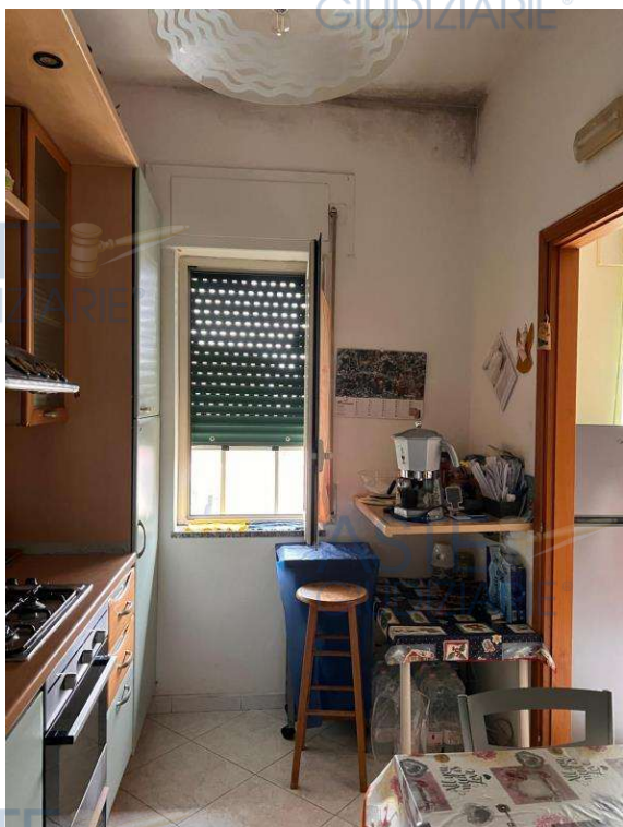
Angolo cottura vista dello stato di infiltrazione e condensa
