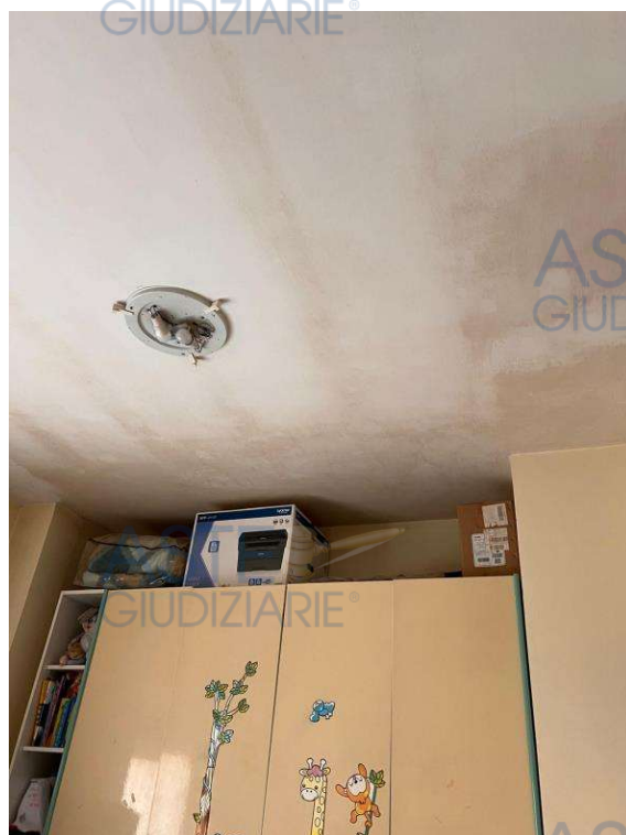
Camera 2 e vista dello stato delle infiltrazioni e condensa
