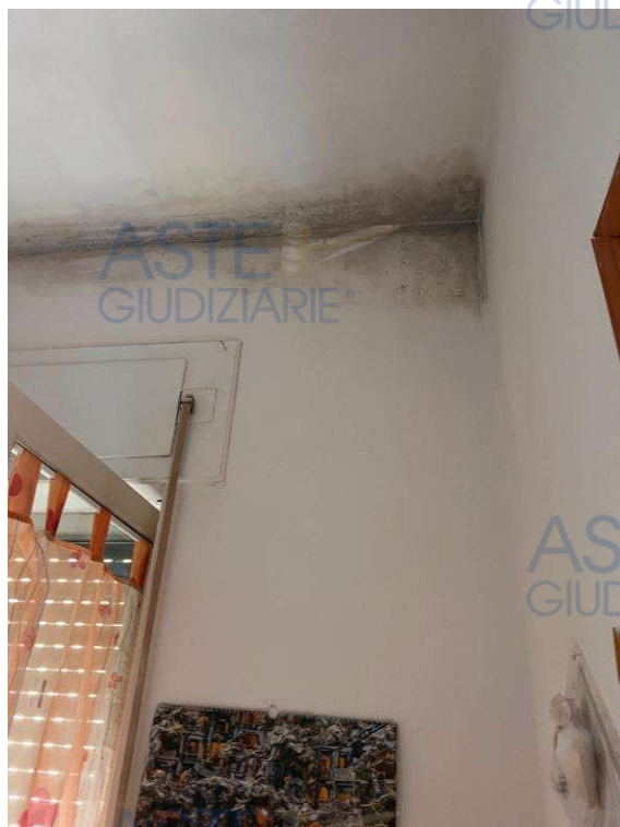
Angolo cottura vista dello stato di infiltrazione e condensa
