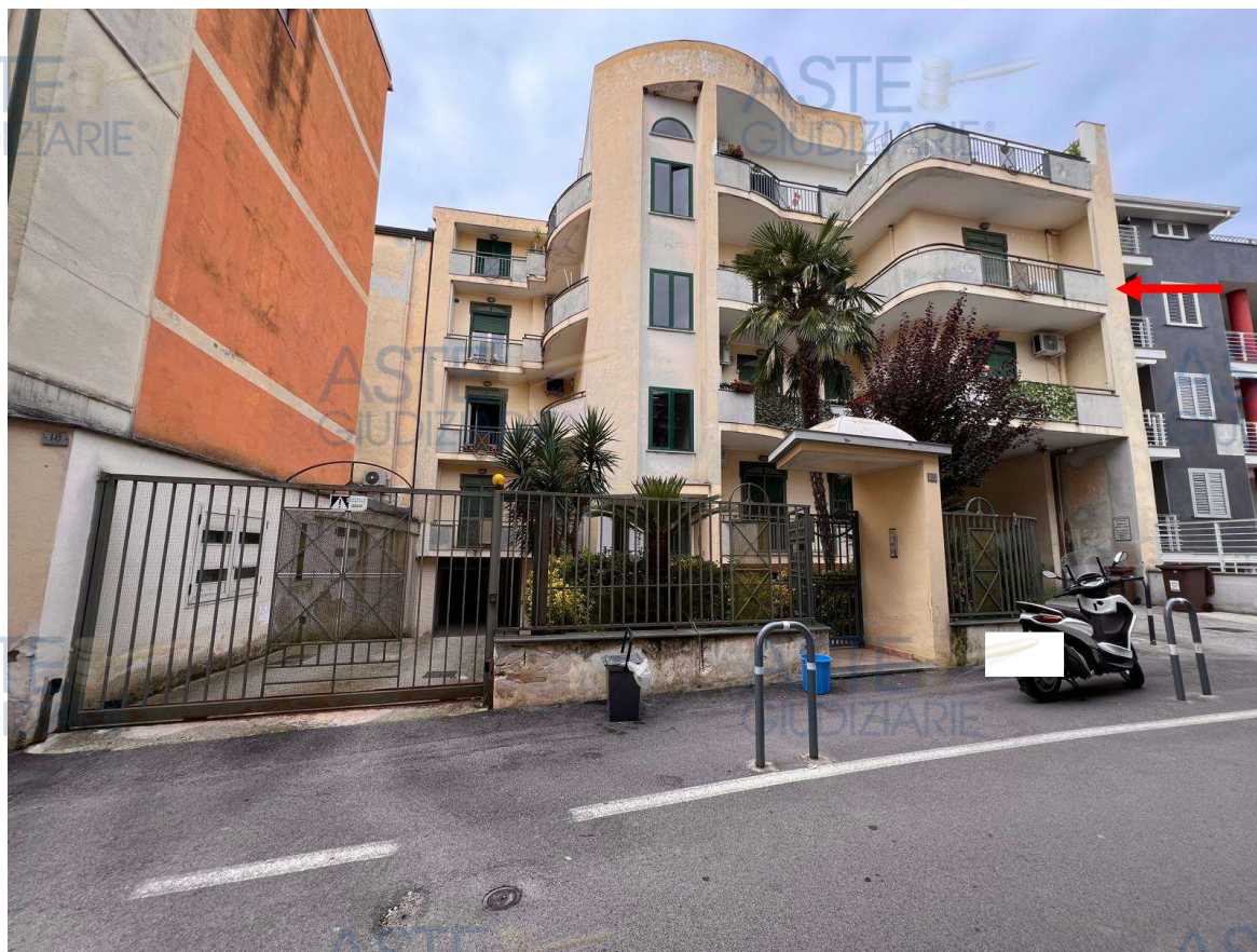
Vista del fabbricato foglio 4, p.lla 5017 dalla via Enrico Toti in cui è inserito al piano secondo l'appartamento e al piano seminterrato il box auto entrambi identificati con il sub. 28 oggetto di pignoramento
