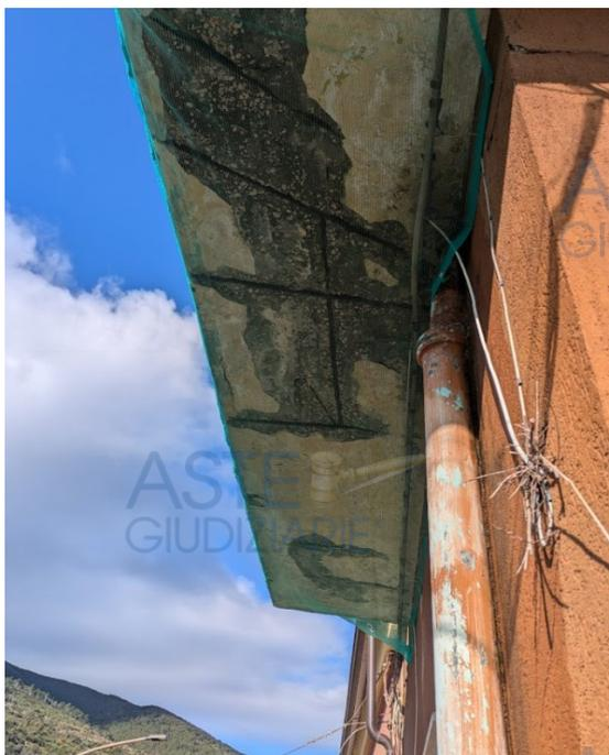
**LAVORI LUNGO VIA DIRETTISSIMA SPICCONATURA INTONACO AMMALORATO**
