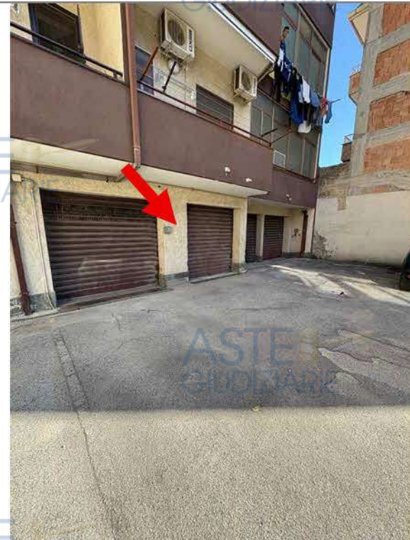
Fotografia n. 5 _ Corte comune e particolare ingresso al box auto
