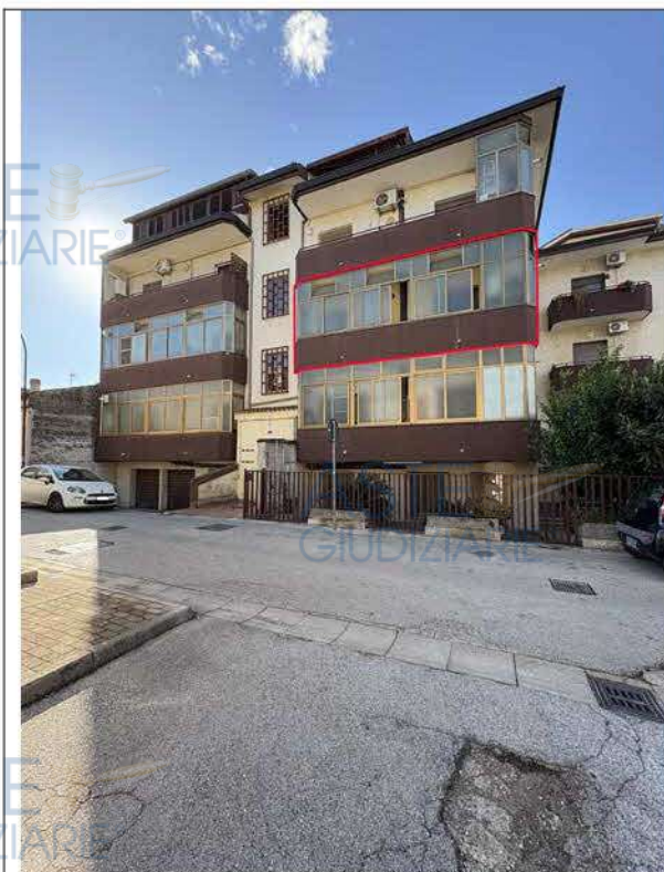
Fotografia n. 1 _ Prospetto del fabbricato su via Napoli e individuazione dell'appartamento pignorato
