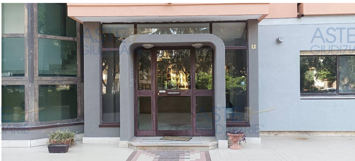
VISTA DELL'ACCESSO AL VANO SCALA A
