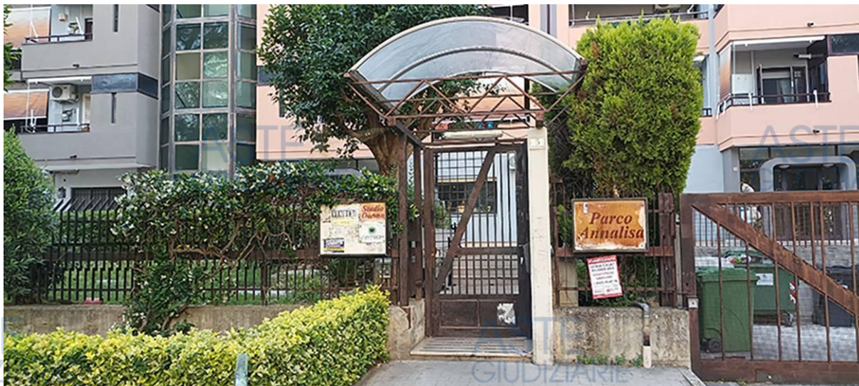
VISTA DELL'ACCESSO DALLA STRADA ALL'EDIFICIO
