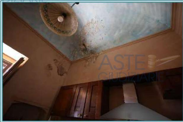
Figura 16 Dettaglio infiltrazione sul soffitto della cucina
