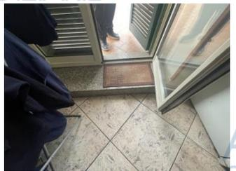
pavimento in gres porcellanato formato cm. 33x33 posato a colla su massetto di sabbia e cemento suggellatura dei giunti con fuga in cemento di colore grigio, spessore cm. 0,5;
