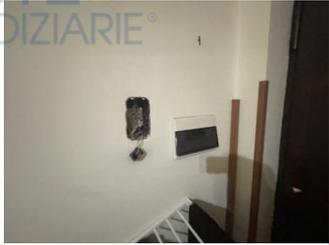
Impianto realizzato con distribuzione interna di tubazioni sottotraccia e sotto pavimento, magnetotermico salvavita, cassette ad incasso, conduttori in rame flessibili per l'alimentazione di interruttori e prese elettriche di servizio; tensione: 220V.
