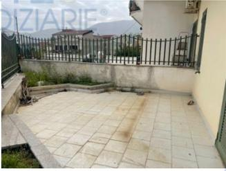
pavimentazione realizzato con piastrelle in clinker posate a colla su massetto di sabbia e cemento, suggellatura dei giunti con fuga in cemento di colore chiaro, spessore cm. 0,3;
