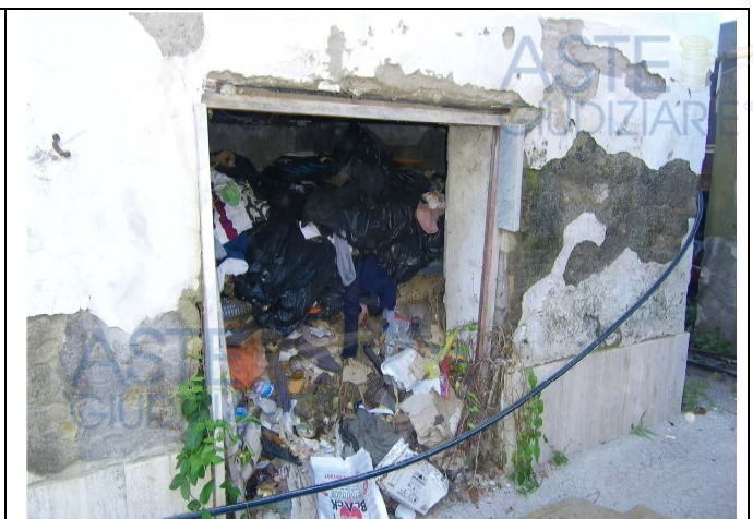
Porta di accesso sul lato Est
