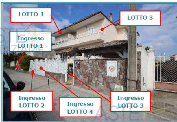
Figura 41 Ingressi al fabbricato da Via Perugia
