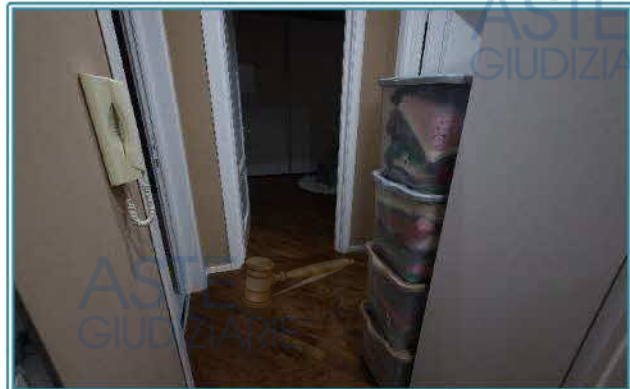
Figura 54 Corridoio (Piano Primo)
