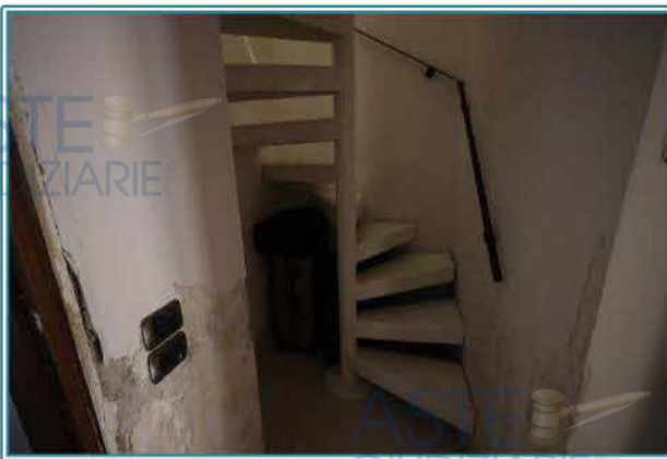
Figura 70 Vano Scala che collega al piano terra (LOTTO 3)
