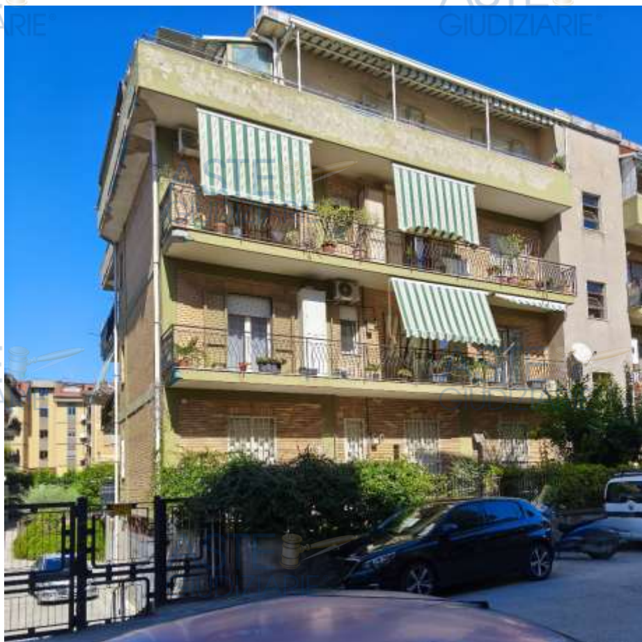
FOTO 1 - 2- 3 Viste esterne del complesso
