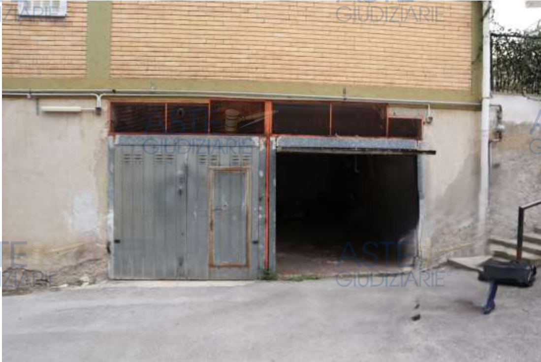
VISTA ESTERNA DEL BOX
