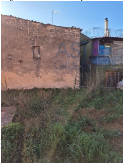
Figura 14 terreno di cui alla particella 5164
