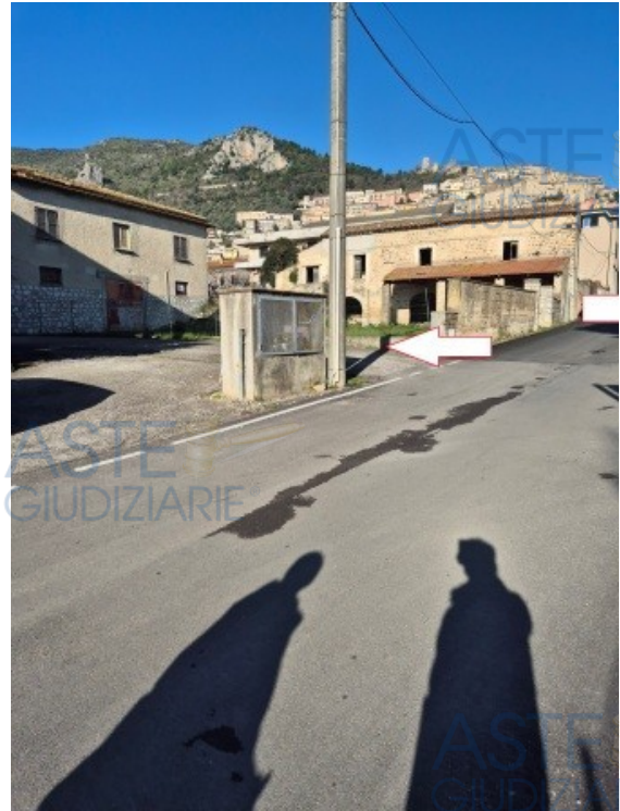
Figura 4 traversa di via Centimolo snc per l'accesso carrabile e pedonale ai terreni in Pietravairano (Ce)
