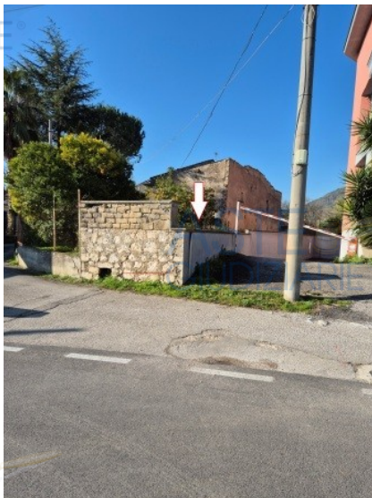
Figura 16 terreno di cui alla particella 5191
