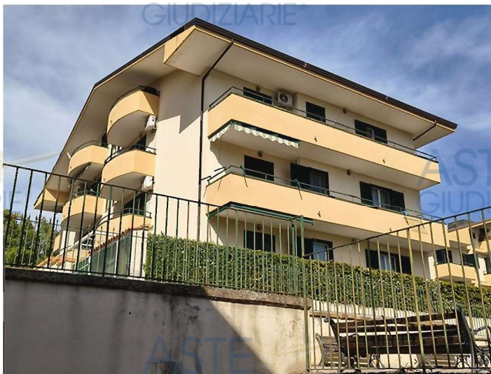
VISTA OVEST E SUD-OVEST
