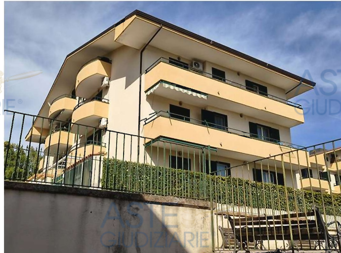
VISTA OVEST E SUD-OVEST
