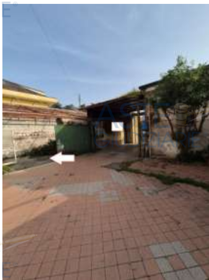
Figura 24 deposito pertinenziale al piano terra p.lla 53
