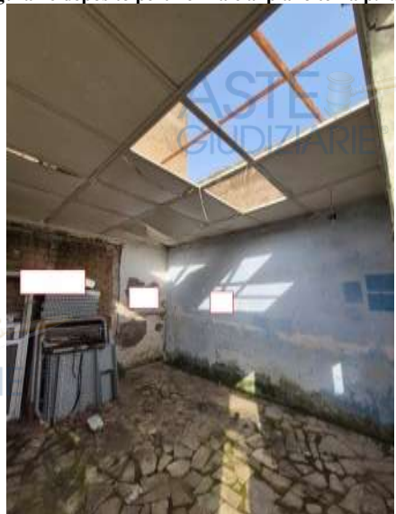
Figura 28 deposito pertinenziale al piano terra p.lla 53
