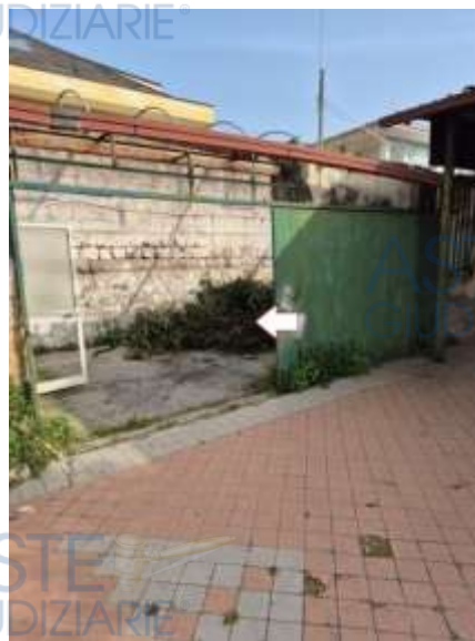
Figura 25 deposito pertinenziale al piano terra p.lla 53
