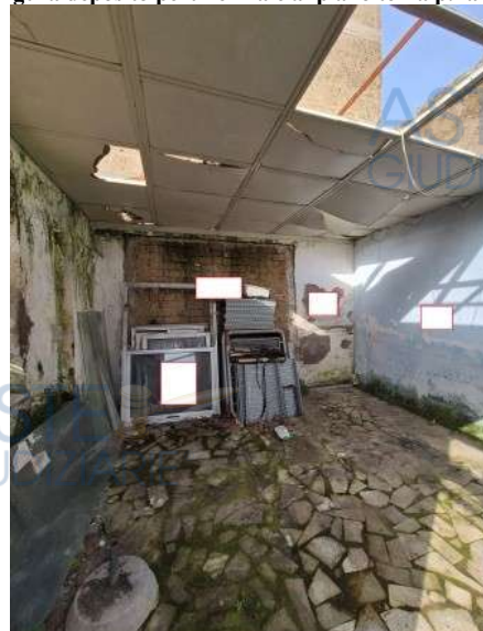
Figura 29 deposito pertinenziale al piano terra p.lla 53
