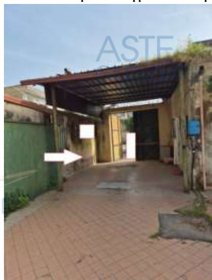
Figura 22 deposito pertinenziale al piano terra p.lla 52
