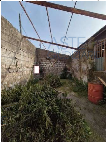
Figura 26 deposito pertinenziale al piano terra p.lla 53
