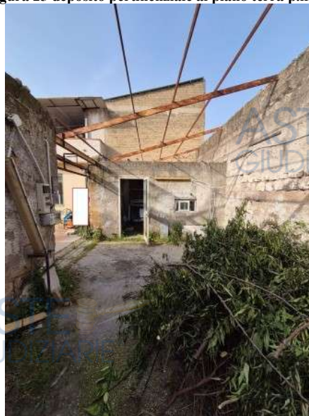
Figura 27 deposito pertinenziale al piano terra p.lla 53
