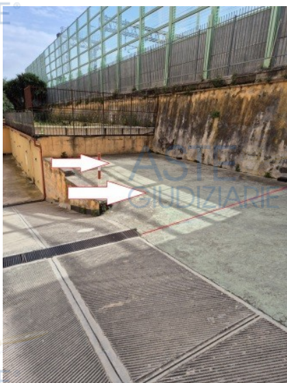
Figura 38 posti auto sub 28 e sub 29
