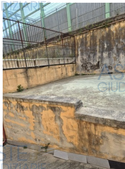
Figura 39 posti auto sub 28 e sub 29
