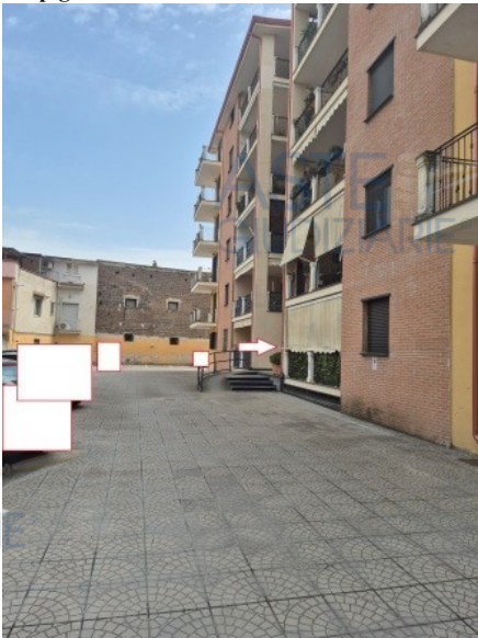
Figura 10 cortile comune con accesso al vano scala
