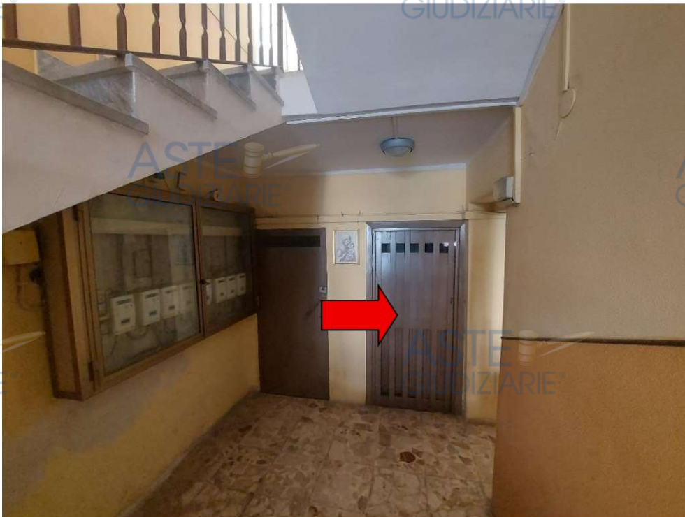
Piano seminterrato – porta accesso cantina
