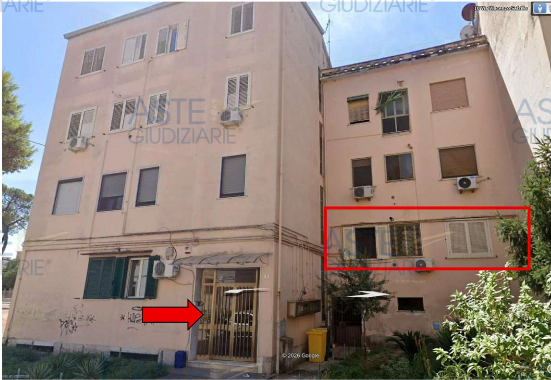
via Salzillo – accesso civ.5 – affacci cespite
