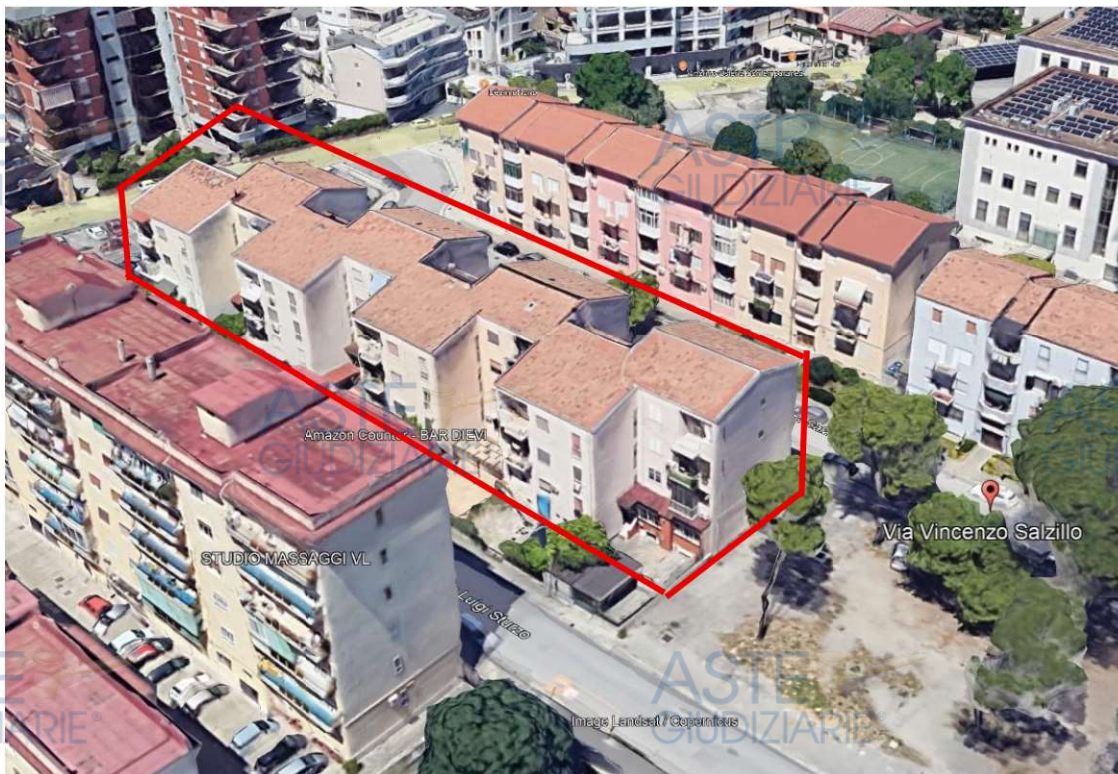
Prospetto sud fabbricato versante via Sturzo
