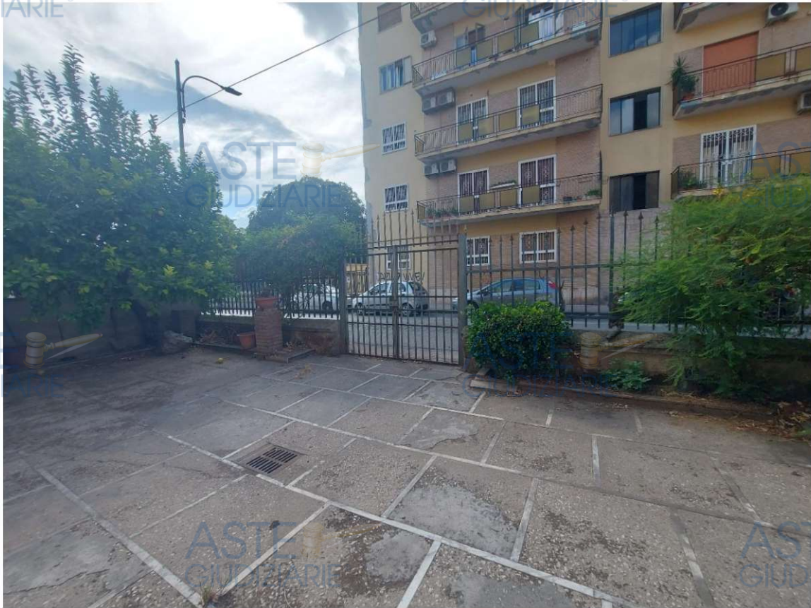
corte di pertinenza – cancello accesso da via Sturzo
