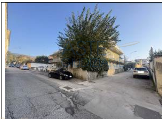
Fotografia n. 3 _ Angolo del fabbricato tra via Molino Militare e via Umberto Nobile
