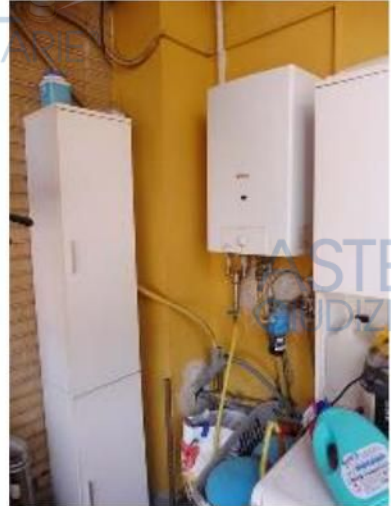
_balcone (lato interno)
