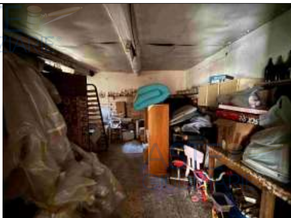
Vista interna locale terraneo sub 9
