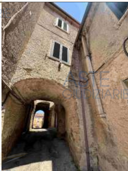
Vista esterna fabbricato
