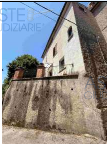
Vista esterna fabbricato
