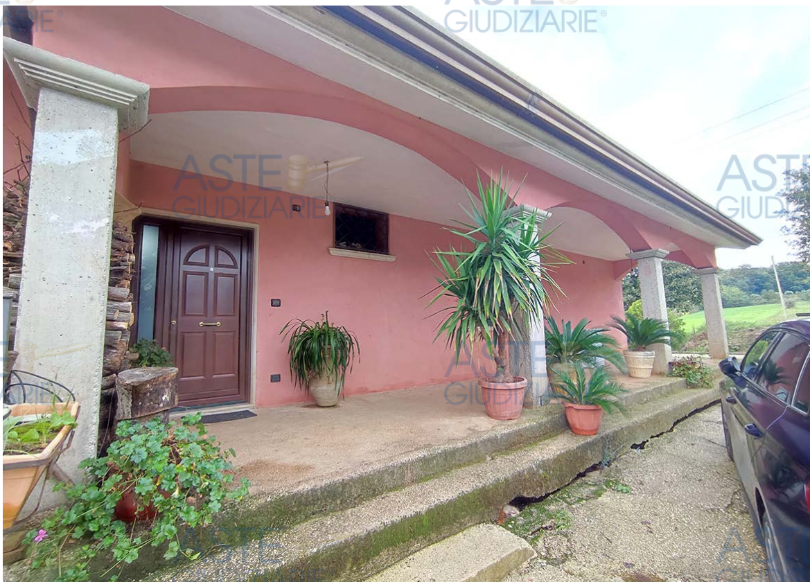
Foto 06. Porta di accesso e porticato (fronte nord est)
