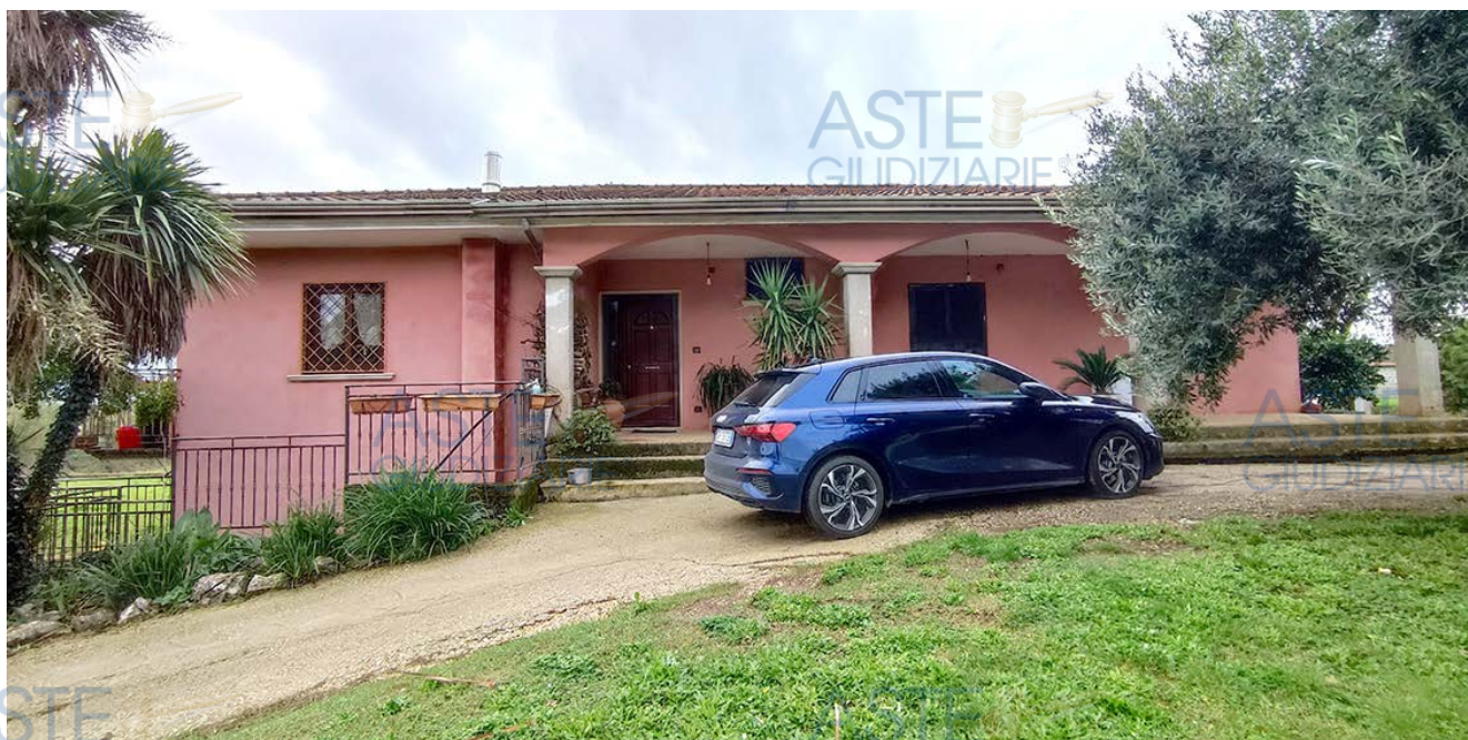
Foto 01. Vista dell'immobile fronte nord est
