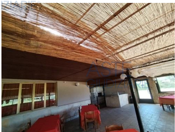
Foto n°4- Vista sala esterna
