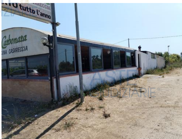
Foto n°2- Vista prospetto laterale ovest
