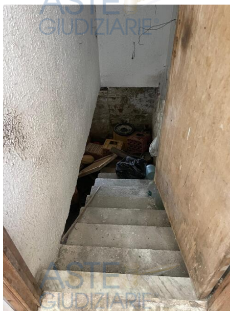
Foto n°9- Vista scala di accesso al piano interrato
