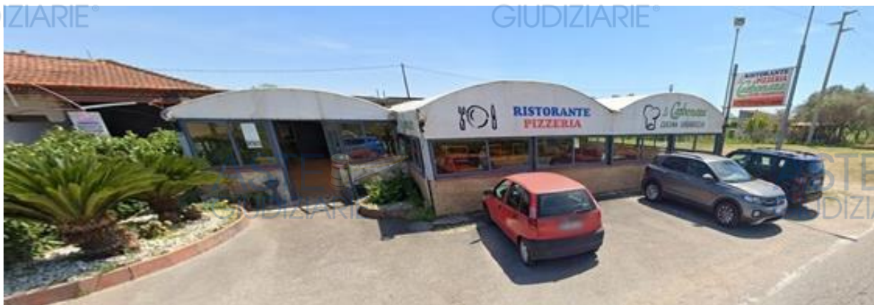
Foto n°1- Vista da via Fontana Vecchia del cespite esecutato – prospetto principale
