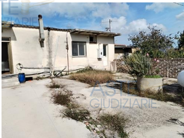
Foto n°11- Vista area pertinenziale retrostante – lato nord-est
