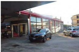
_vista dal piazzale
