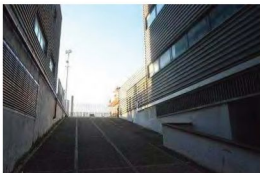
_accesso dal piazzale interno
