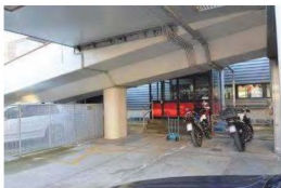
_accesso dal piazzale interno
