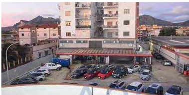
__vista della tettoia
