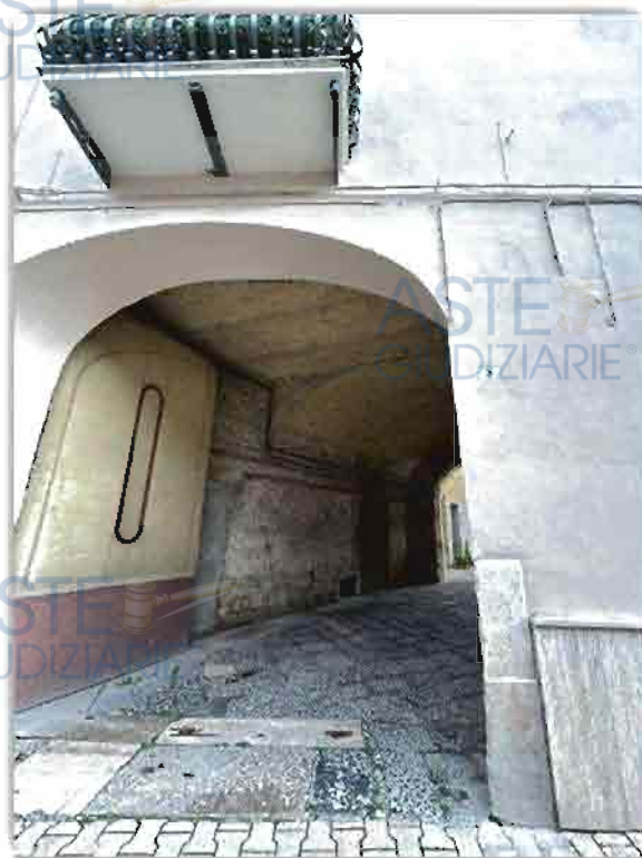
Accesso pedonale e carrabile alla corte ad uso esclusivo dell'immobile pignorato (particella n. 129)
