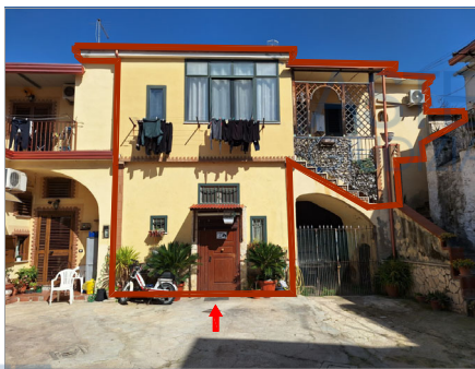
Piano Terra Sub 10 - Accesso dal cortile comune
