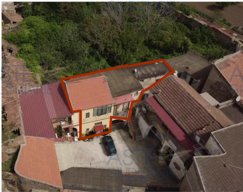
Ripresa aerea eseguita con ausilio di APR (drone) Inquadramento prospettico del compendio pignorato Foglio 41 - P.Ila 5047 - Sub 10 e Sub 15
