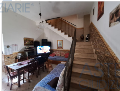
Scala interna in c.a. di collegamento piano terra e primo
