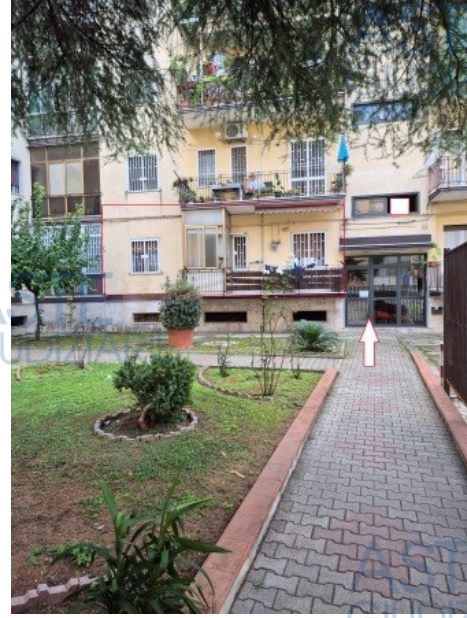
Figura 4 accesso alla scala C della palazzina n.6 da via Tevere in Caserta e facciata della scala C
