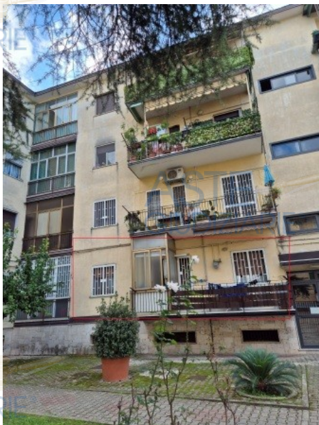
Figura 6 facciata della scala C della palazzina n.6 in via Tevere n.5 - Caserta
