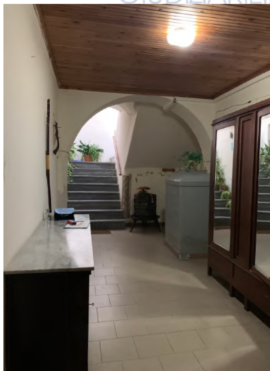
Foto n.3 – ingresso comune coperto
