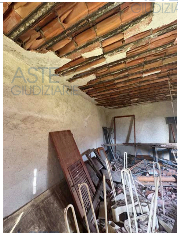
Fotografia n. 16 _ Deposito p.la 5238 al piano primo
