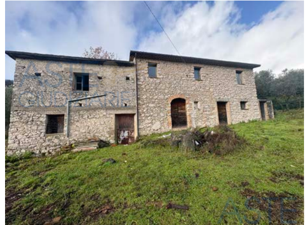
Fotografia n. 2 _ Prospetto principale del casolare
