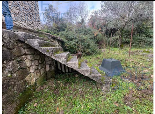
Fotografia n. 6 _ Scala di accesso al piano primo dell'unità p.la 5235 sub 1
