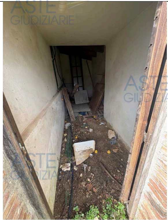
Fotografia n. 14 _ Cantinola p.la 5235 sub 1 al piano terra
