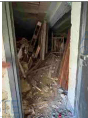
Piano seminterrato - Vista locale deposito 2
