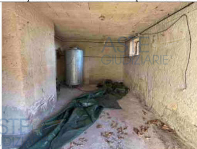
Piano seminterrato - Vista locale deposito 1
