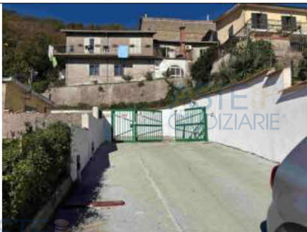
Ingresso al parco dalla strada pubblica
