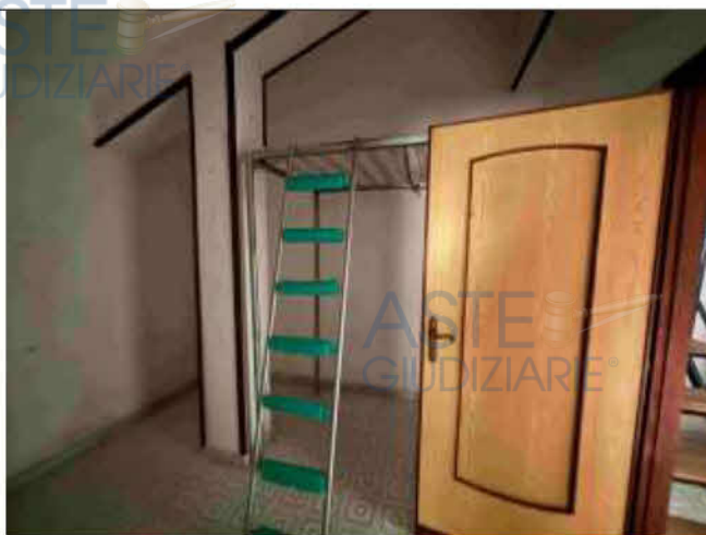
Piano Primo – Vista cabina
