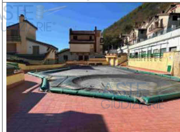
Vista piscina condominiale
