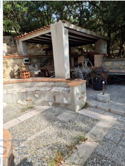
Figura 53 tettoia 4 al piano terra
