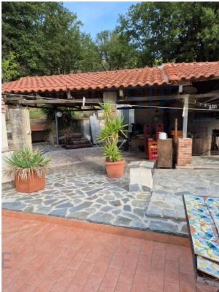
Figura 66 tettoia 3 al primo piano pertinenziale – sub 6
