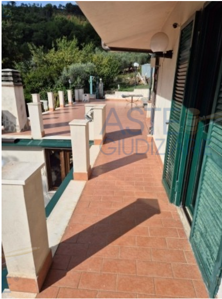
Figura 46 balcone 1 al primo piano
