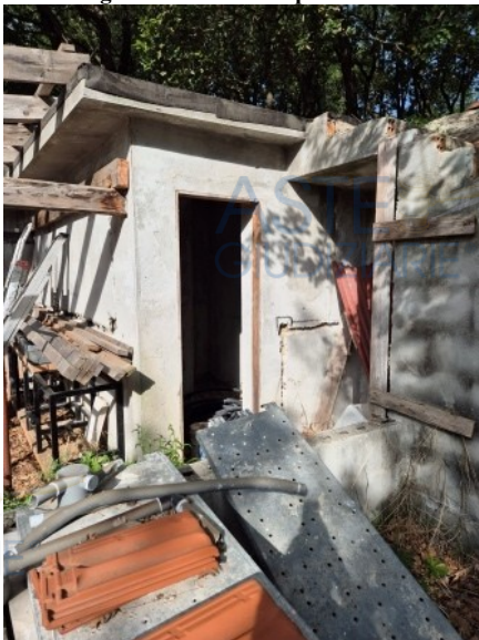
Figura 54 deposito 3 al primo piano
