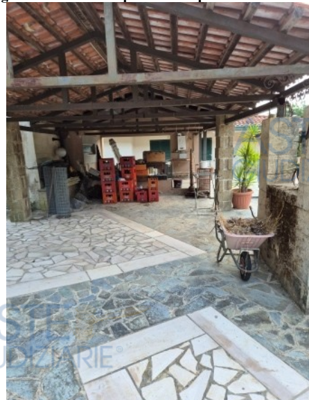
Figura 67 tettoia 3 al primo piano pertinenziale – sub 6
