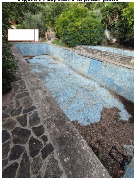
Figura 56 piscina 1 al piano terra
