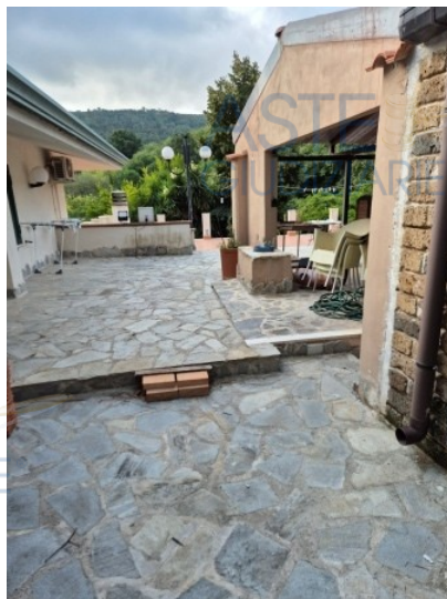
Figura 50 cortile 2 al primo piano
