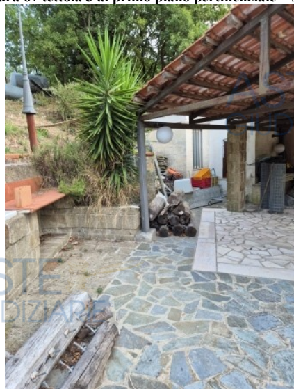
Figura 69 tettoia 3 al primo piano pertinenziale – sub 6
