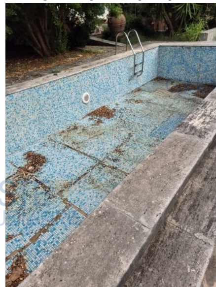
Figura 57 piscina 2 al piano terra
