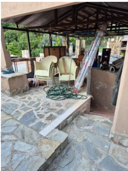
Figura 68 tettoia 3 al primo piano pertinenziale – sub 6
