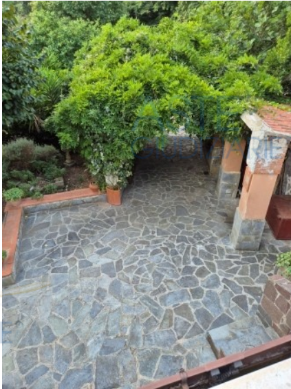
Figura 48 cortile 1 al piano terra
