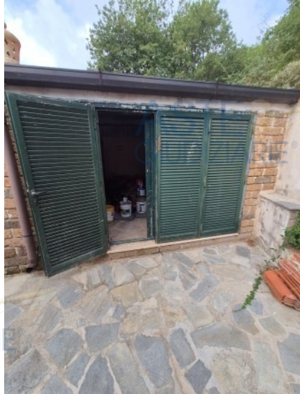
Figura 60 accesso ai depositi 1 e 2 al primo piano pertinenziale – sub 4
