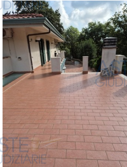
Figura 47 balcone 1 al primo piano
