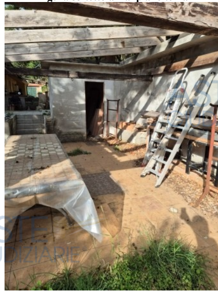
Figura 55 deposito 4 al primo piano
