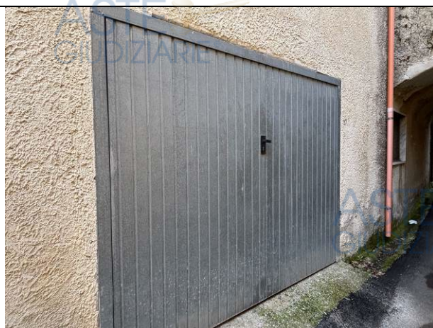
Vista esterna sub 9
