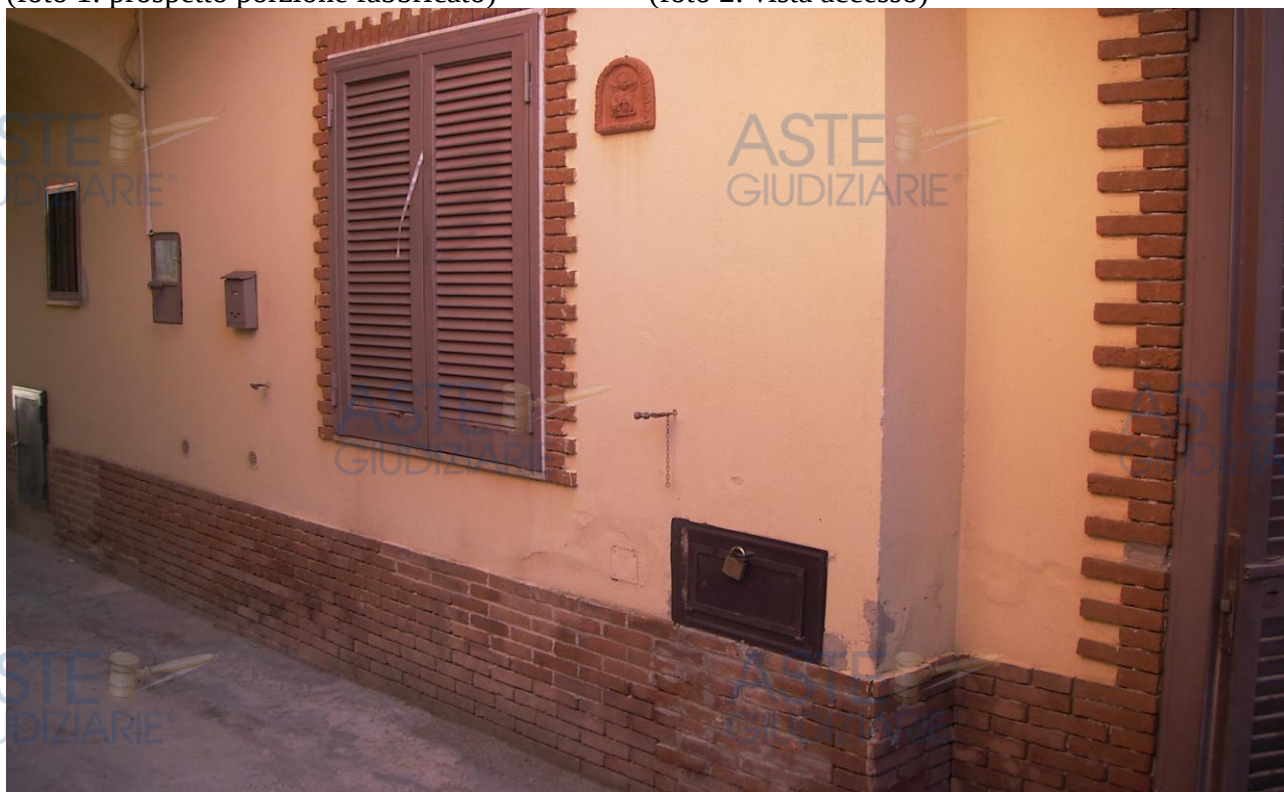
(foto 3: prospetto porzione fabbricato)
