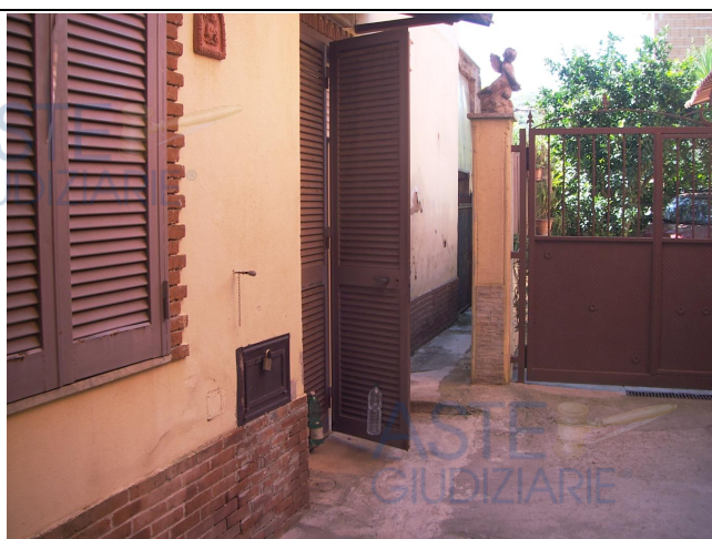
(foto 1: prospetto porzione fabbricato)
