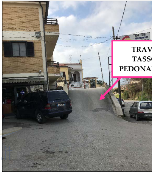
Rampa di accesso
