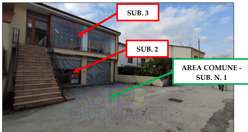
Facciata esterna fabbricato
