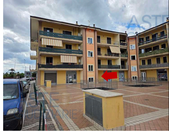
Vista cortile comune con indicazione dell'accesso al vano Scala "A"
