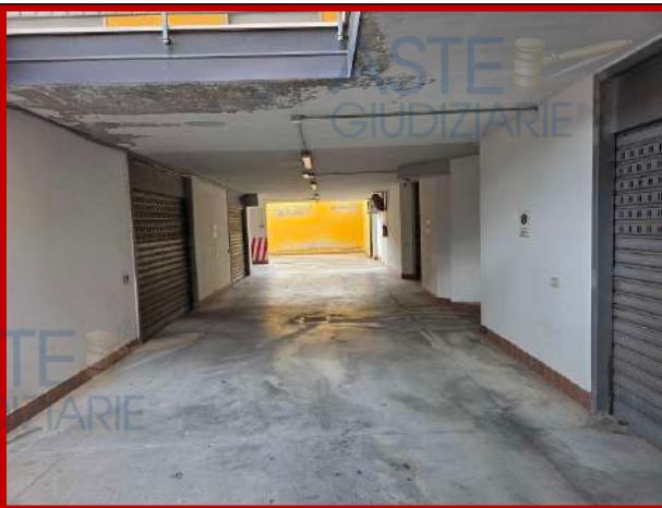
- Vista corsia di manovra -
