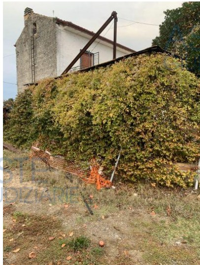
Retro tettoia aperta
