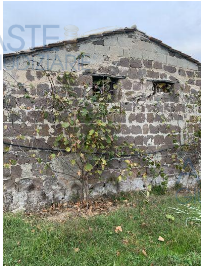
Retro tettoia e locale di sgombero
