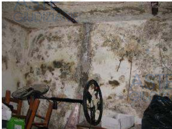
Viste dei locali a piano terra
