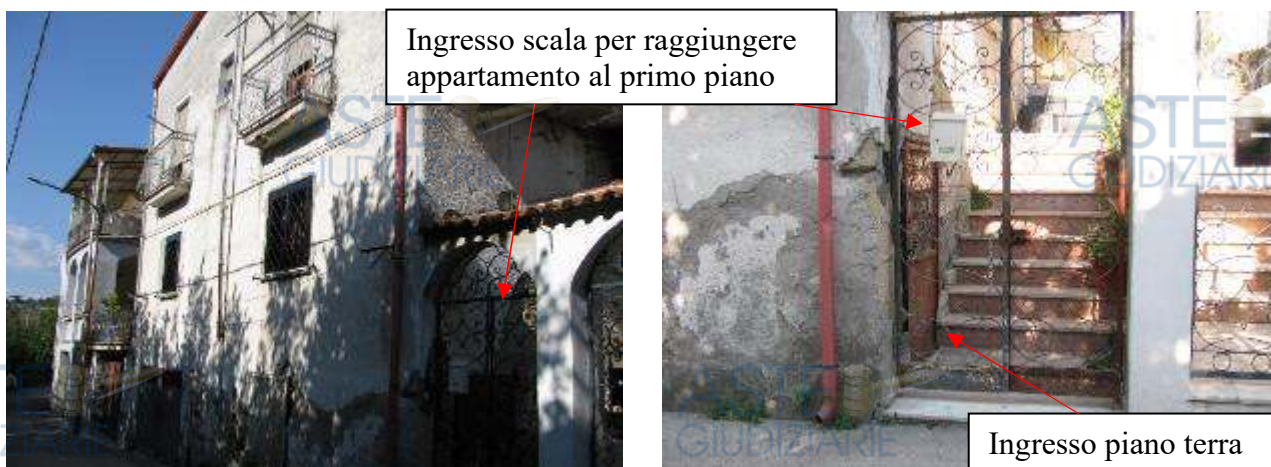
Viste esterne dell'unità abitativa da via Carità
